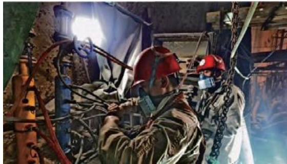
图4 最终接头焊接施工现场
